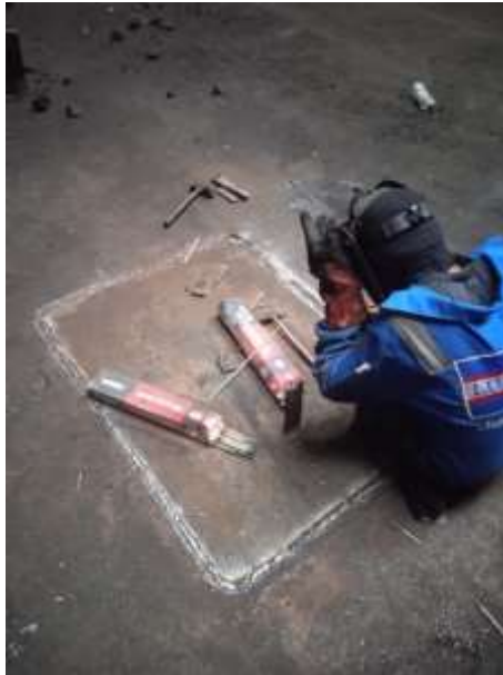
Gambar 4. Proses Perbaikan Bagian yang Mengalami Kebocoran.
