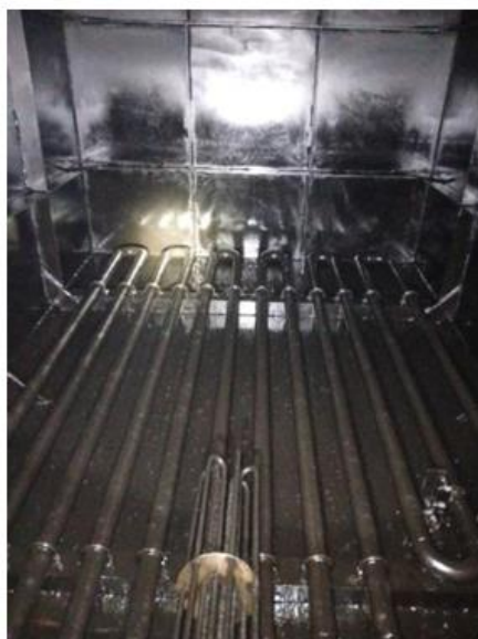
Gambar 2. Service Tank sebelum Dibersihkan.
